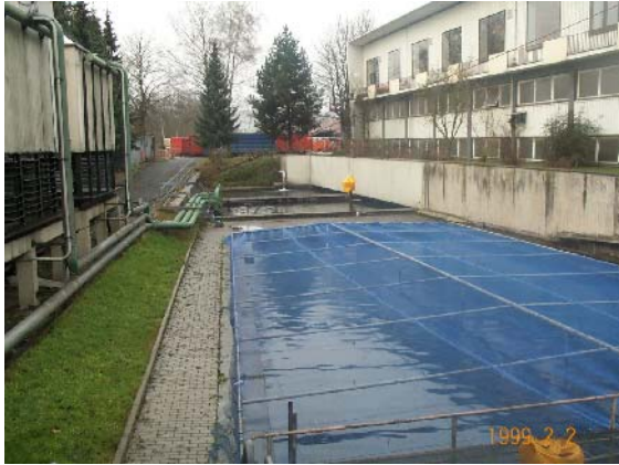
Bild 1.3 Dieses Becken wird durch die Leitstelle überwacht.
